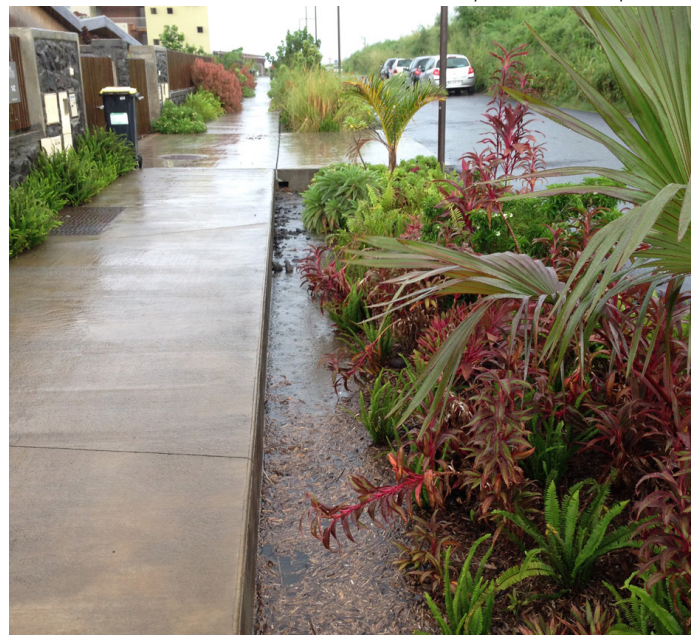
Exemple de gestion de l'infiltration d'eaux pluviales en espace public Atelier LD, ZAC Beauséjour
