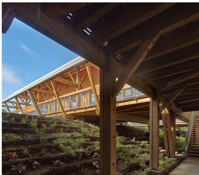
Le goyavier est idéal en fascines pour réaliser des terrasses paysagères
