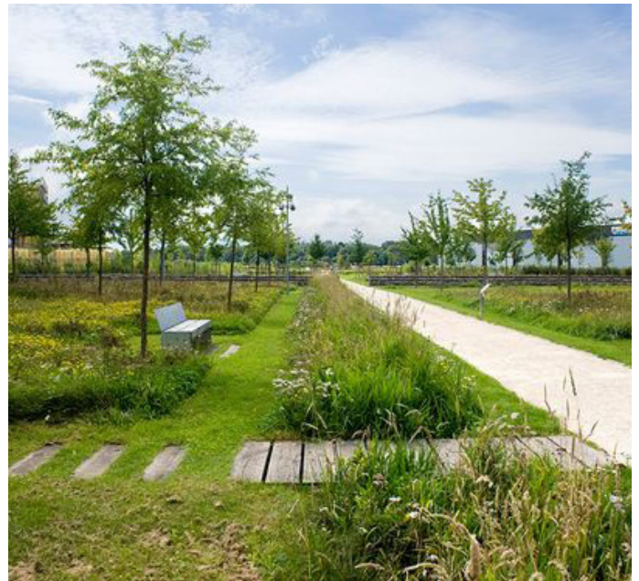
Exemple d'une noue plantée
