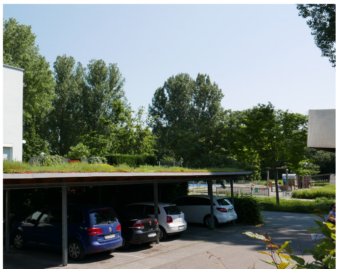
Une couverture sera possible soit par une structure bois légère type pergola ou par un toit végétalisé pour une intégration paysagère efficace.
